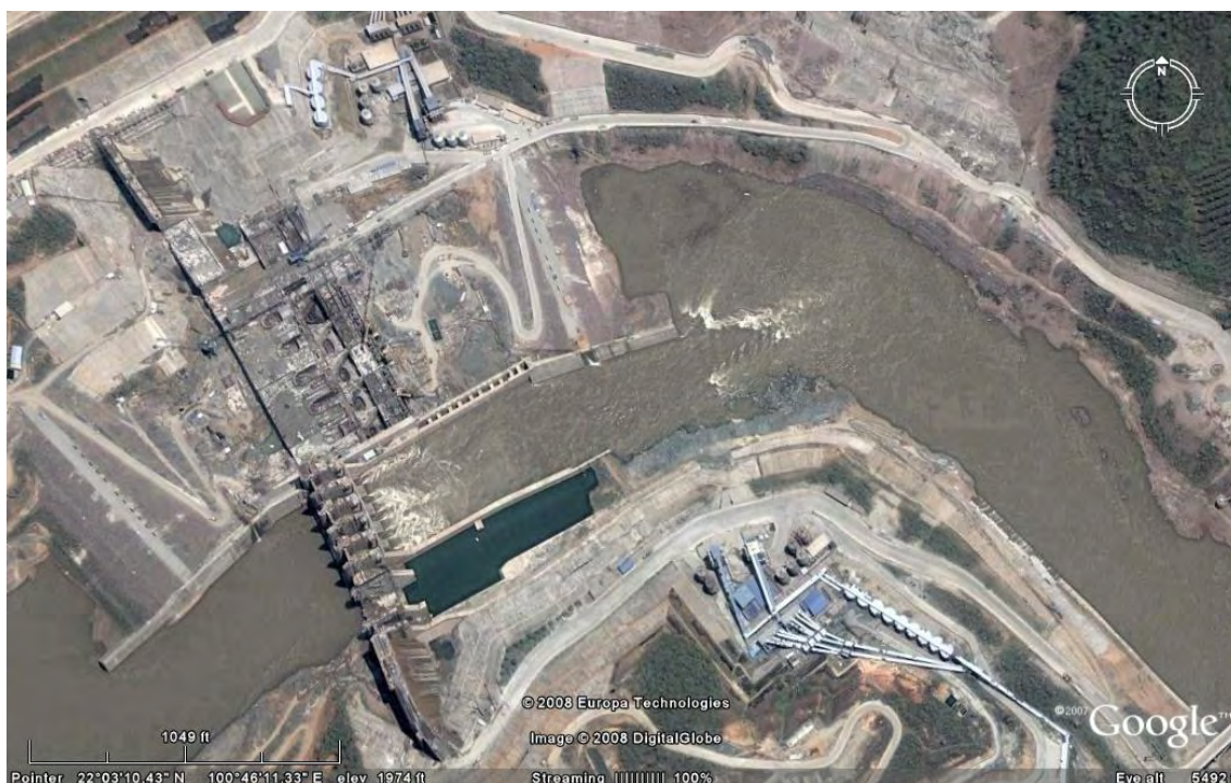
ภาพ 3 เขื่อนจิ่งหงก่อสร้างแล้วเสร็จ
